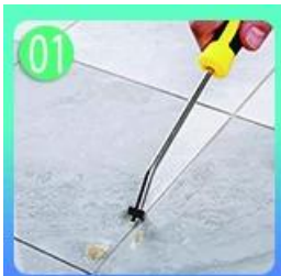
01 إزالة الحبيبات المتبقية من الفتحة باستخدام مسدود الحبيبات
