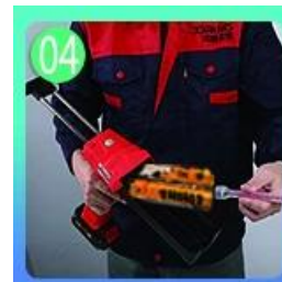
04 حفر ثقب في الجدار باستخدام مسدس كهربائي.
