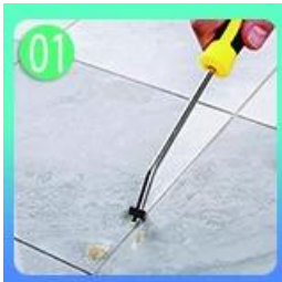
01 تنظيف السطح باستخدام أداة صفراء.
